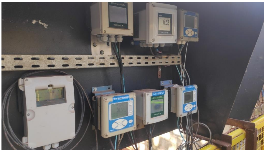
Figura 8-4 – Painel de leitores do Monitoramento Automático Contínuo.
