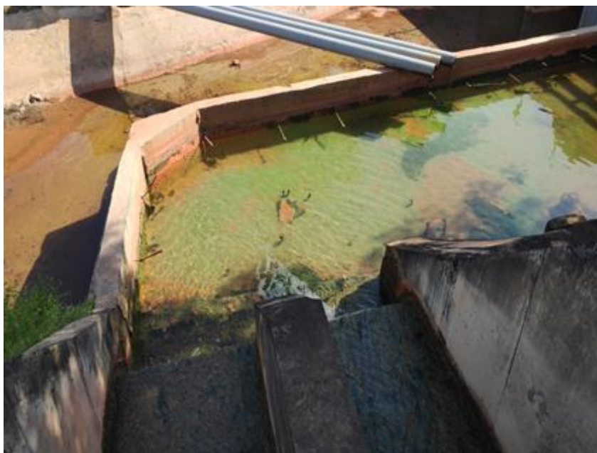
Figura 8-2 – Canal de lançamento do efluente tratado no rio Pará.
