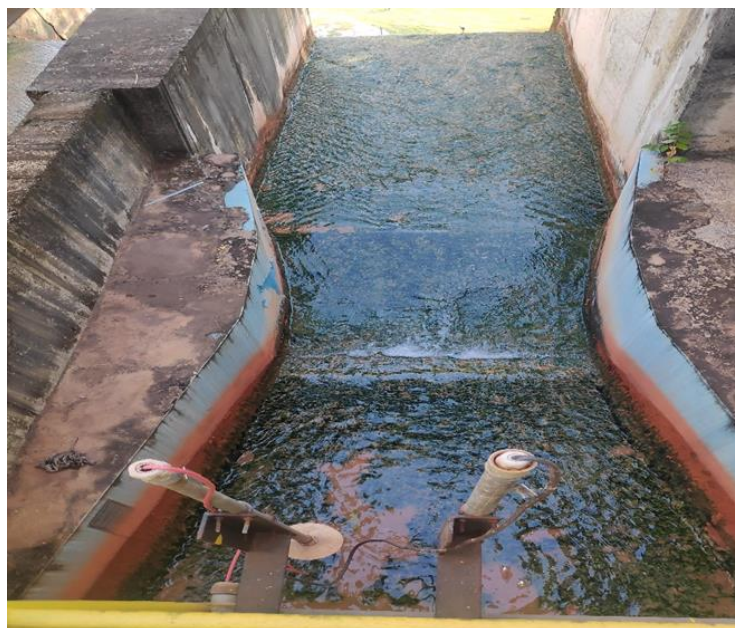
Figura 8-1 – Calha Parshall.
