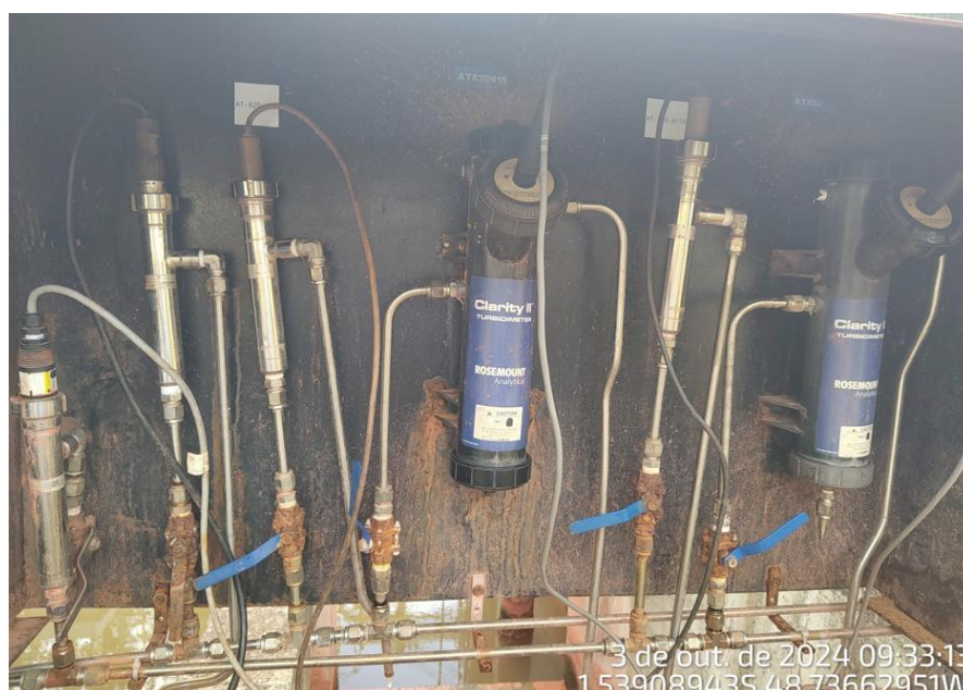
Figura 8-5 – Painel de instrumentos do Monitoramento Automático Contínuo – em detalhe, turbidímetros.
