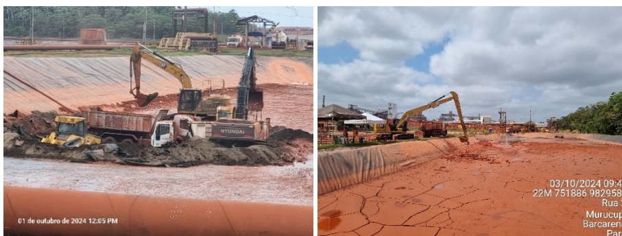
Figura 11-5 - Remoção do resíduo acumulado nas bacias de espera.
