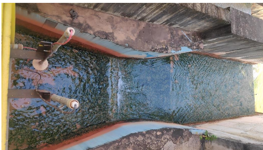
Figura 11-2 - Calha Parshall na saída do tratamento. Fonte Tractebel (2024).
