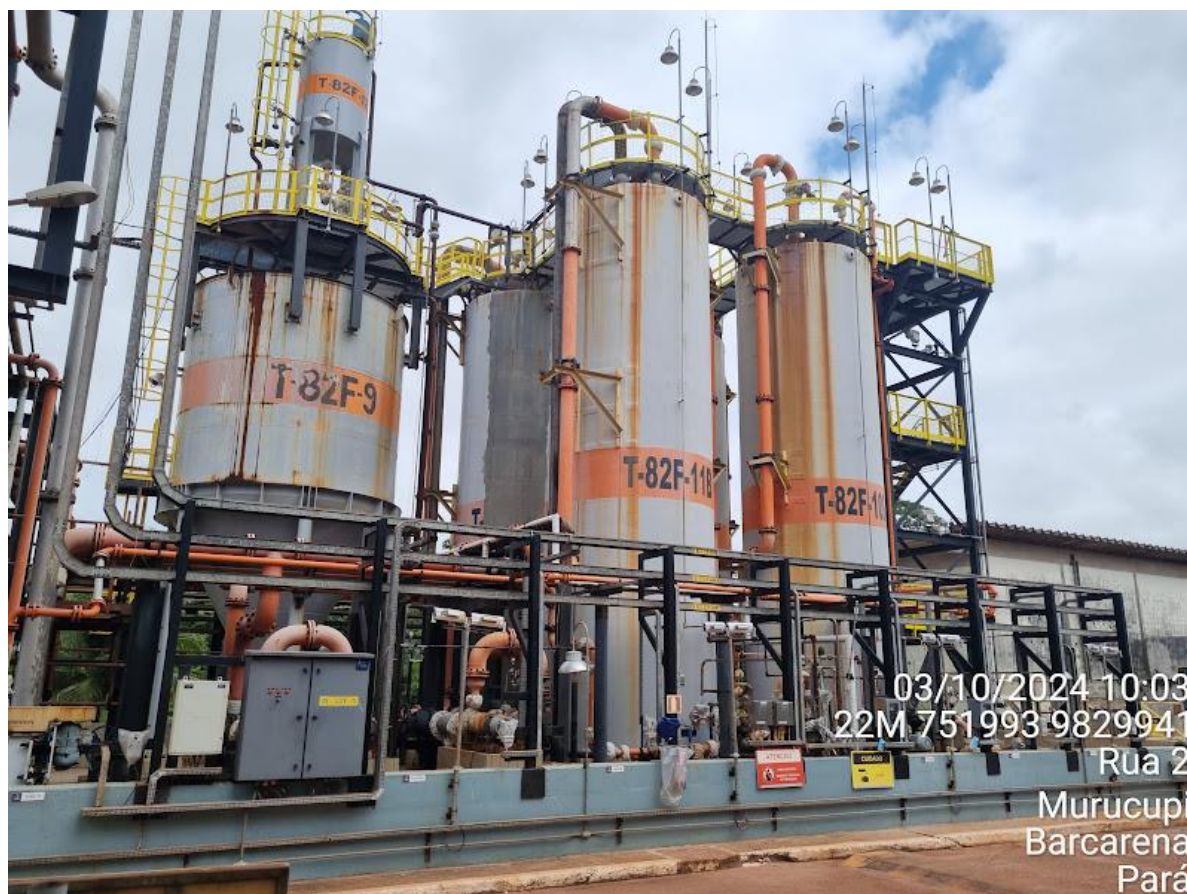
Figura 9-3 - Tanques de neutralização do efluente com ácido sulfúrico. Fonte Tractebel (2024).
