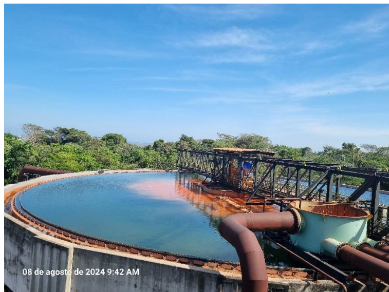
Figura 9-4 - Decantado/clarificado da ETEI. Fonte: Tractebel (2024).
