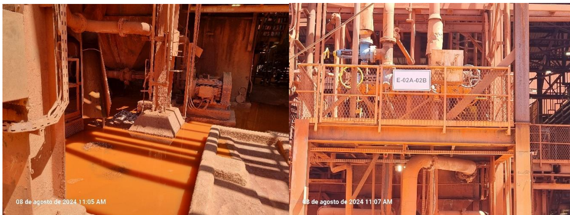
Figura 10-3: Bacias de contenção da refinaria.
