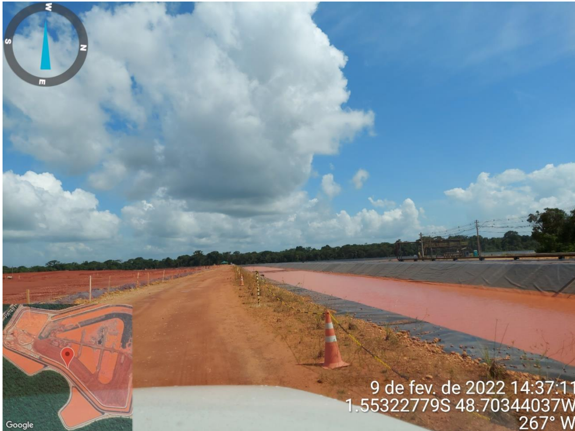
Figura 5.8 – Canal de contorno adjacente ao DRS2
