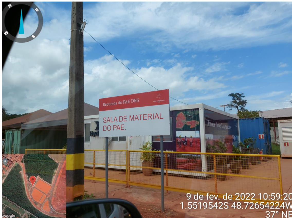
Figura 7.15 – Contêiner com materiais de uso em caso de acionado do PAE.
