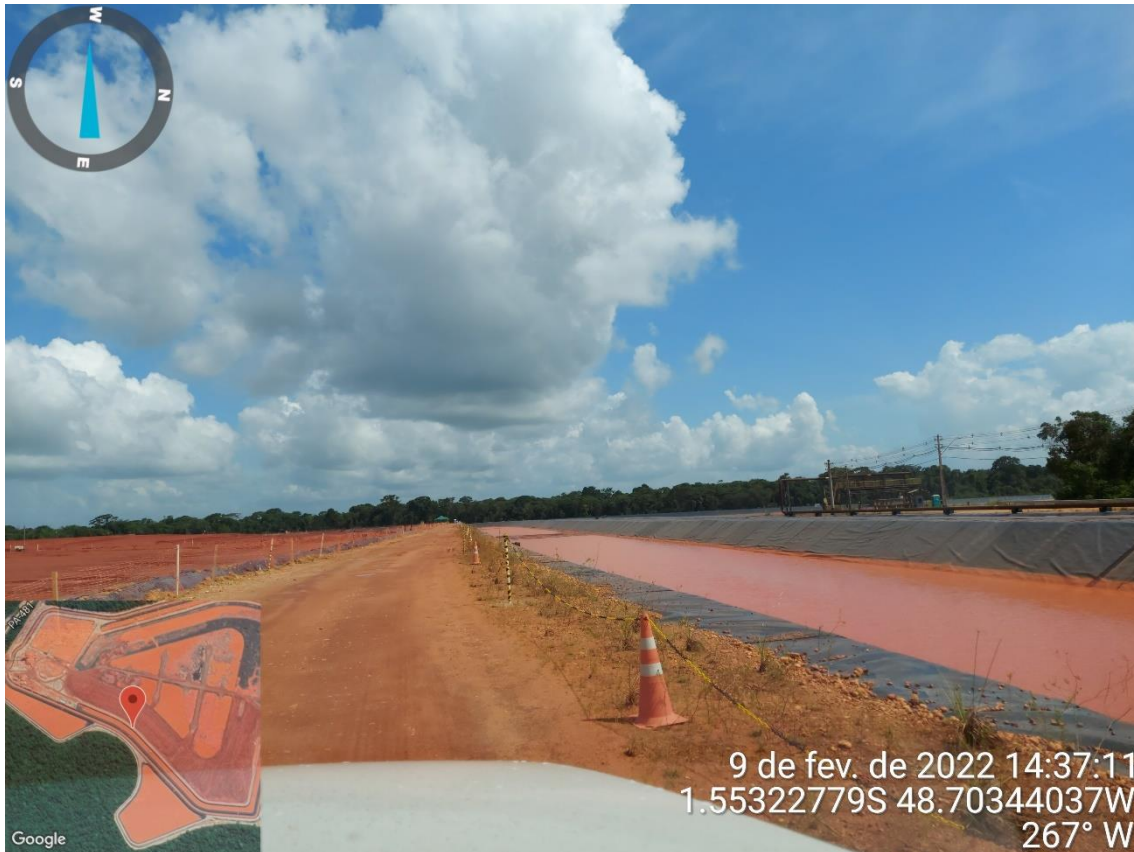
Figura 5.8 – Canal de contorno adjacente ao DRS2
