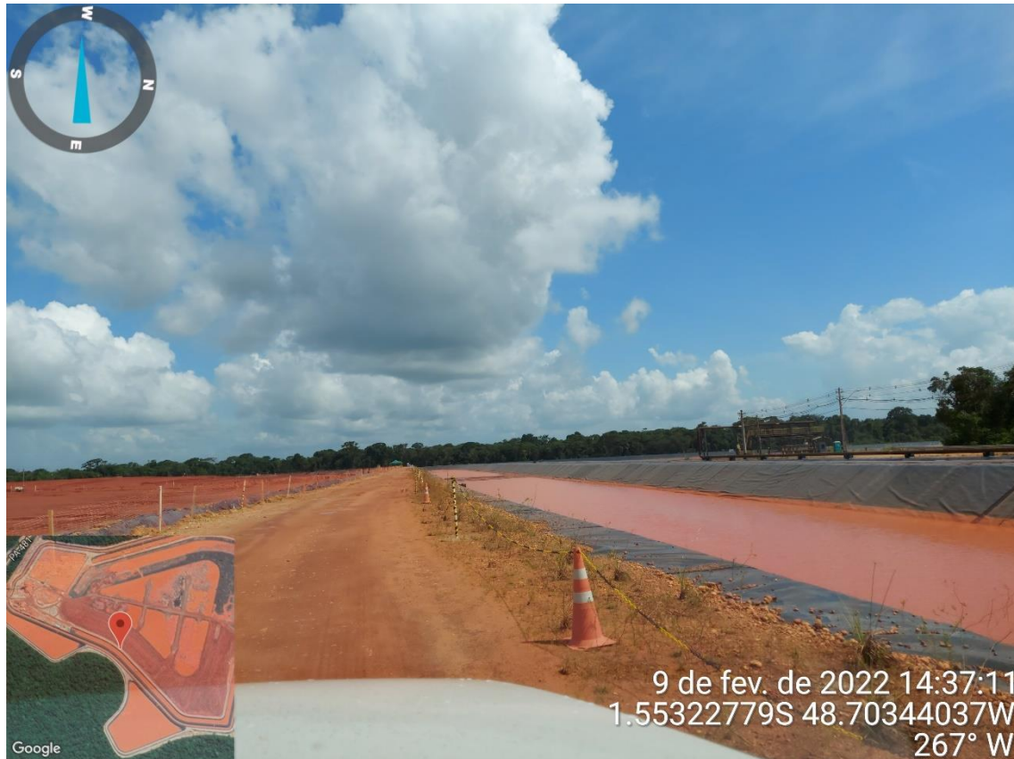
Figura 5.8 – Canal de contorno adjacente ao DRS2
