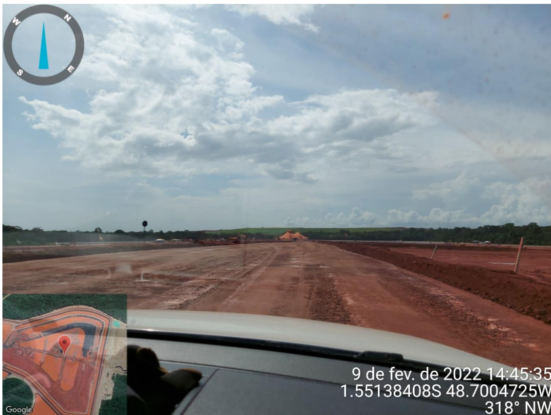
Figura 5.10 – Dique central e fingers – infraestrutura inicial do DRS2
