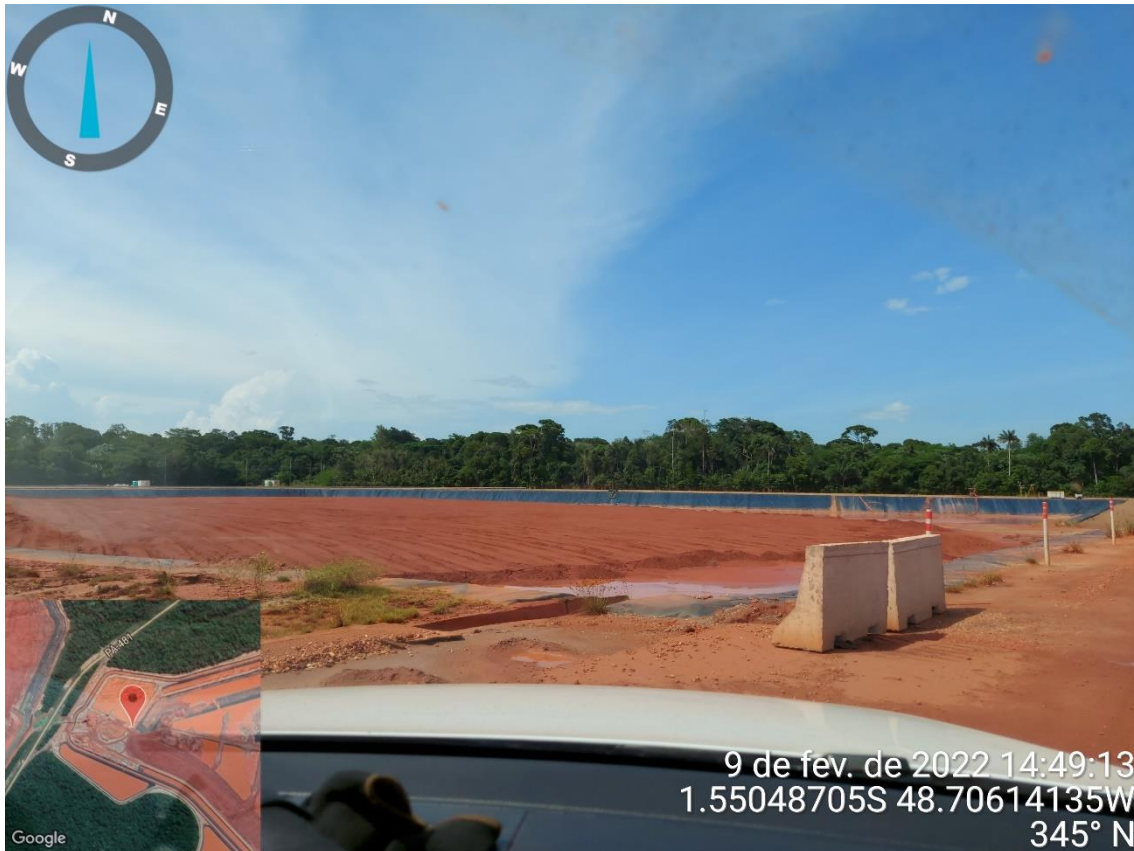
Figura 5.7 – Bacia de emergência
