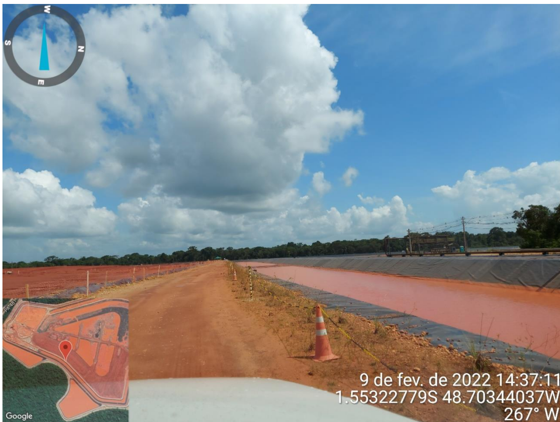
Figura 5.8 – Canal de contorno adjacente ao DRS2
