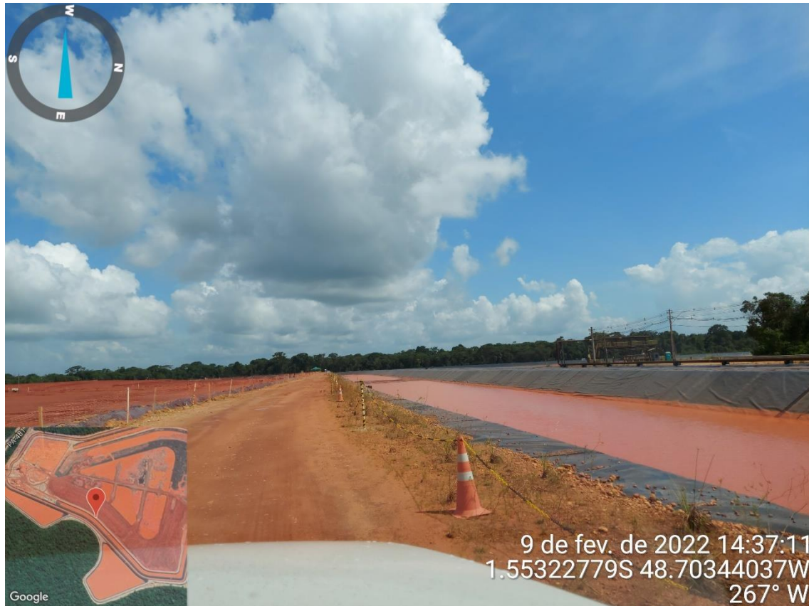
Figura 5.8 – Canal de contorno adjacente ao DRS2
