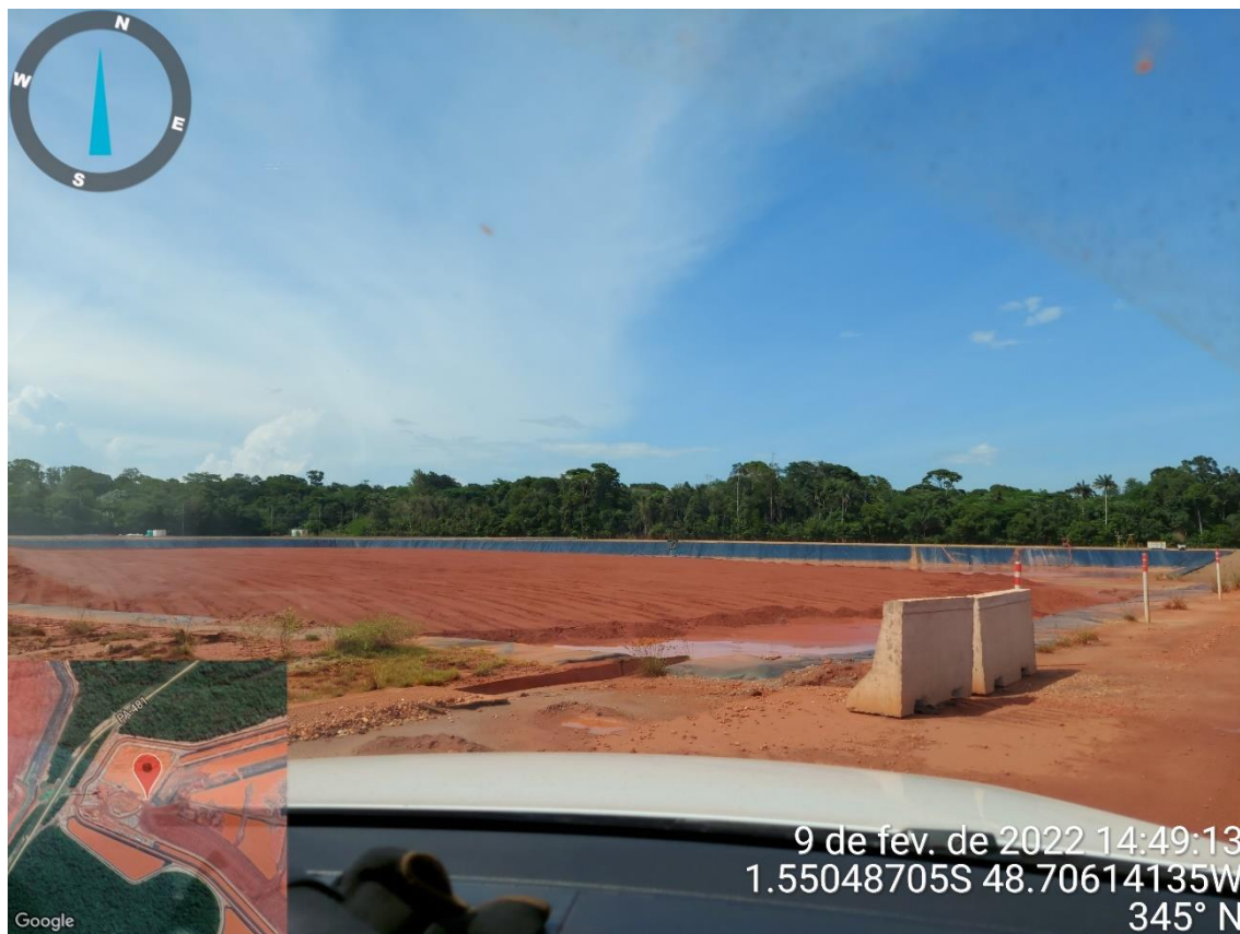
Figura 5.7 – Bacia de emergência
