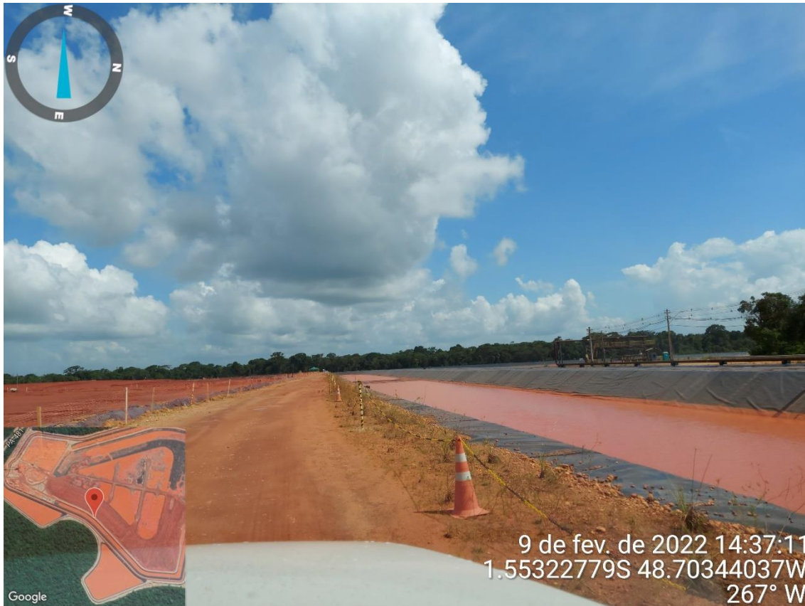
Figura 5.8 – Canal de contorno adjacente ao DRS2
