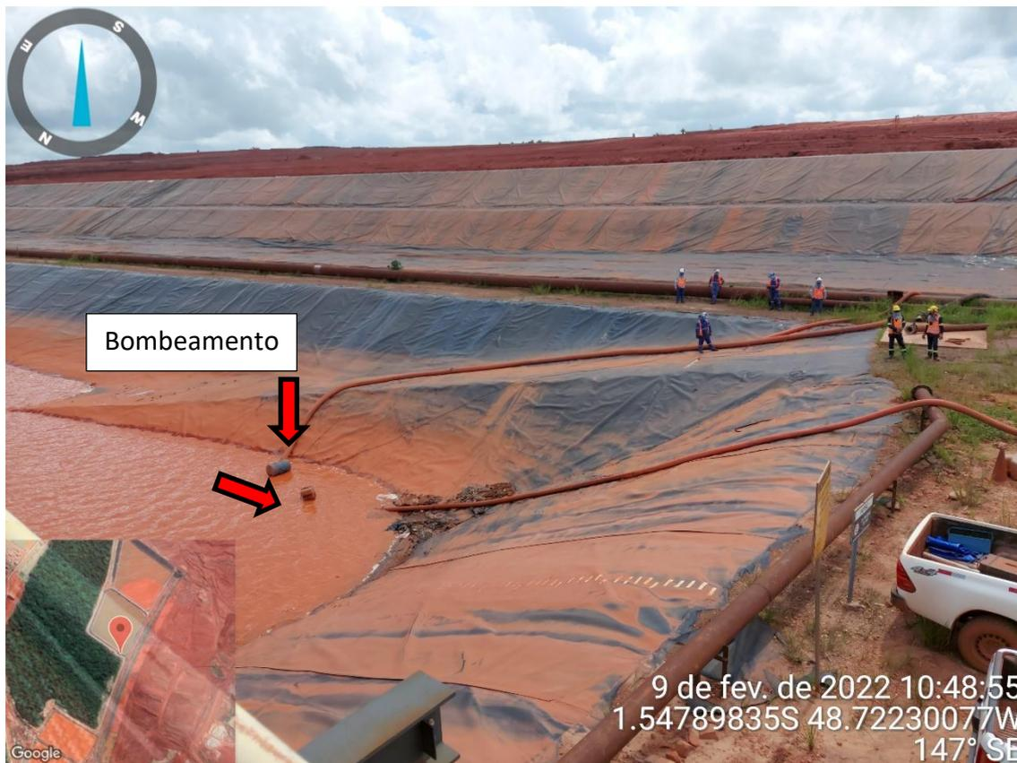
**Figura 7.9 – Ação de rebaixamento do nível do BC 06 em andamento no dia da visita técnica, mesmo estando o reservatório no nível normal (09/02/2022).**
