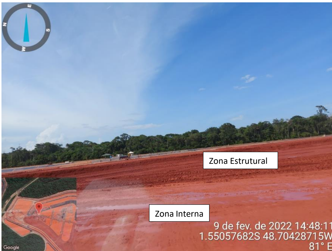
Figura 7.8 - Depósito DRS2 – Zona interna e zona estrutural (FONNTES, 09/02/2022)
