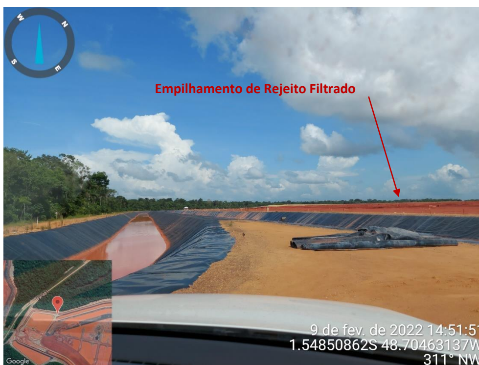
Figura 7.4 – Depósito DRS2 – Empilhamento de Rejeito Filtrado ( dry stacking ) (FONNTES, 09/02/2022)
