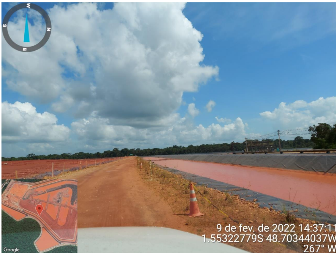
Figura 5.8 – Canal de contorno adjacente ao DRS2
