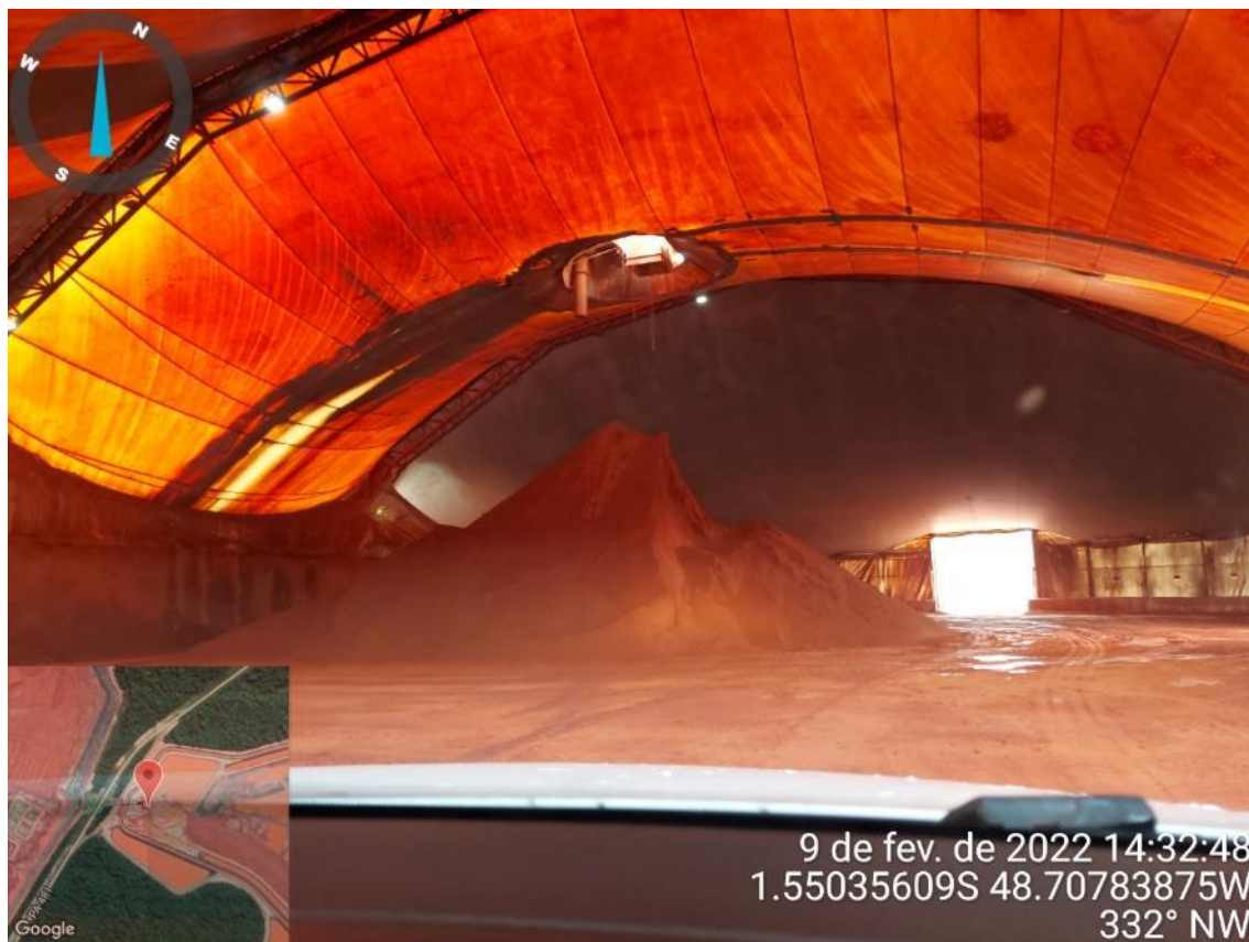
Figura 7.10 – Depósito DRS2 – Galpão para estocagem temporária dos rejeitos (FONNTES, 09/02/2022)
