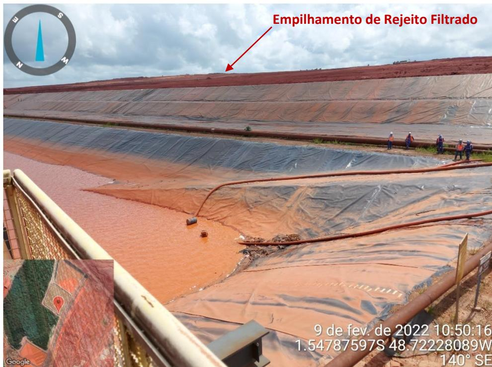
**Figura 7.4 – Depósito DRS1 – Empilhamento de Rejeito Filtrado (dry stacking) (FONNTES, 09/02/2022)**
