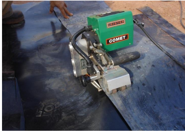
Figura 7.13 – Teste para avaliação da qualidade da Solda – Célula Sul (RECORD, 2008)
