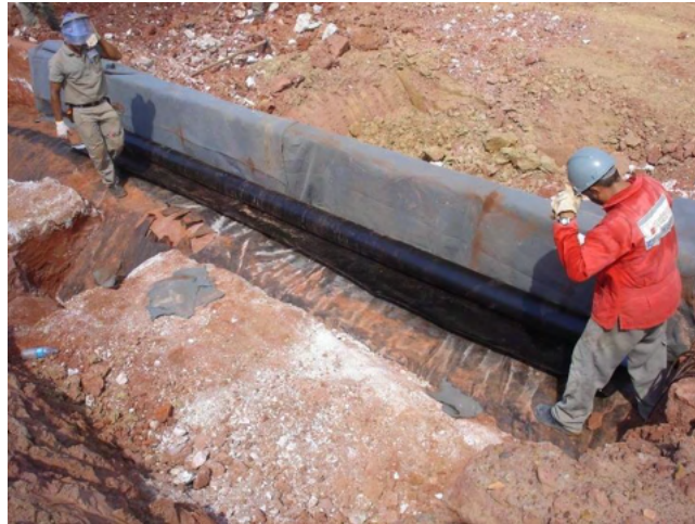
Figura 7.11 – Proteção do Muro com Geotêxtil e alinhamento da Geomembrana para confecção da Solda – Célula Sul (RECORD, 2008)
