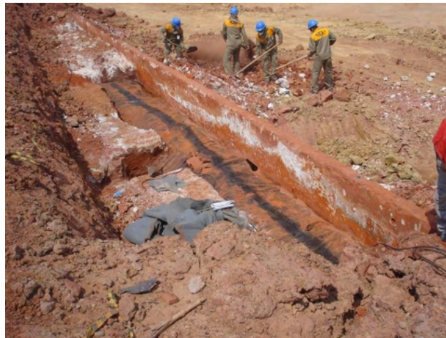
Figura 7.10 – Limpeza da Geomembrana para realização de Solda por Extrusão – Célula Sul (RECORD, 2008)
