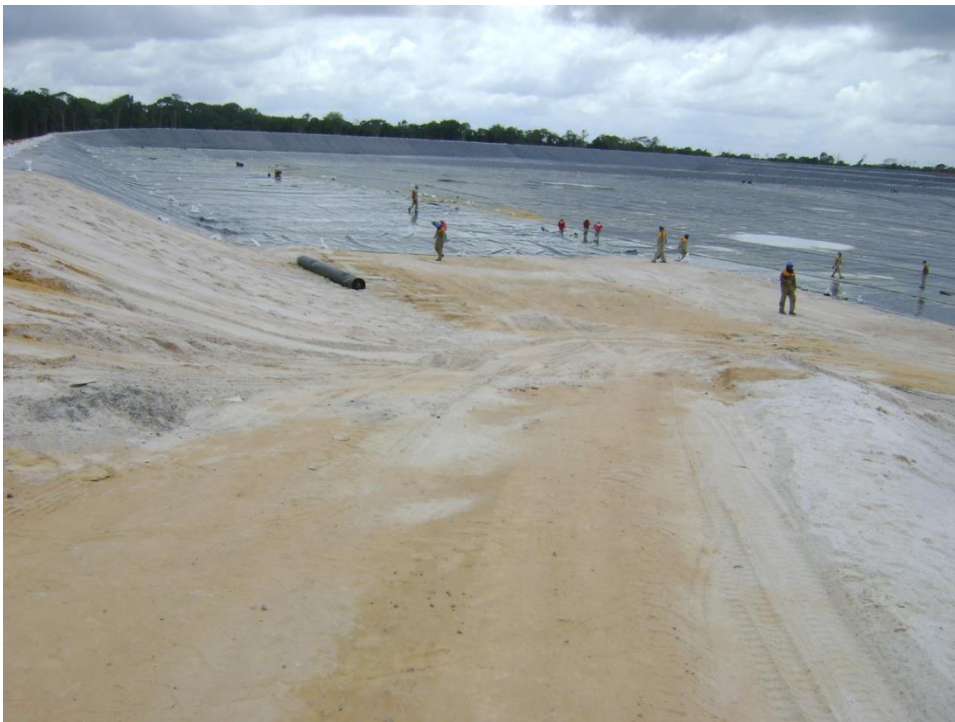
Figura 7.20 – CL1: Aplicação de geomembrana no interior do reservatório
