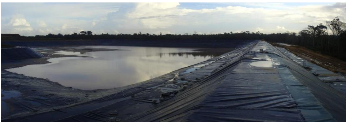
Figura 7.17 – Obra de impermeabilização da Célula Sul finalizada – março/2008 (RECORD, 2008)
