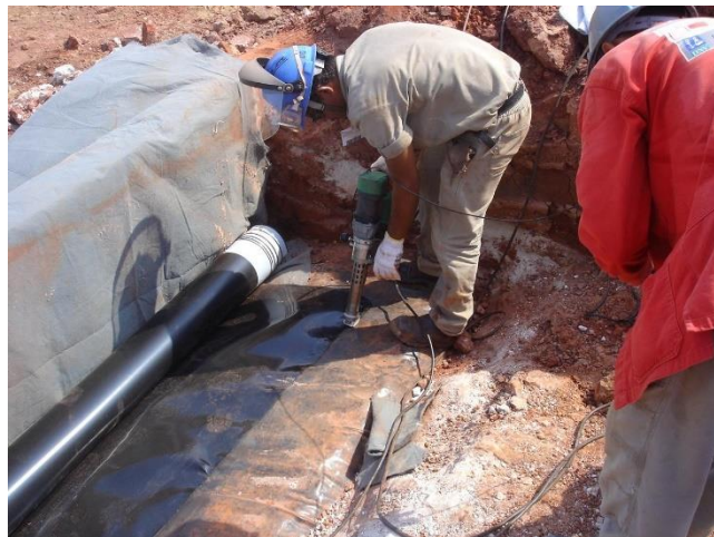
Figura 7.12 – Solda da Geomembrana Velha com a Nova por Extrusão – Célula Sul (RECORD, 2008)
