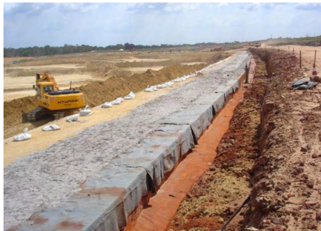
Figura 7.14 – Envolvimento do muro com geotêtil para proteção da Geomembrana – Célula Sul (RECORD, 2008)
