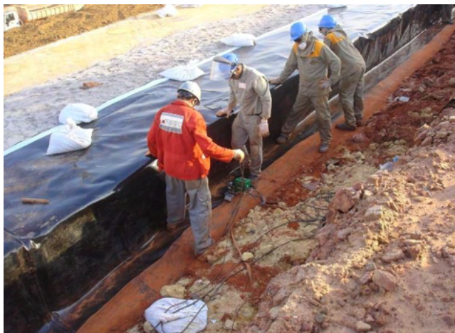
Figura 7.15 – Solda da geomembrana Velha com a Nova (Solda dupla a cunha Quente) para confecção da espera, ou seja, Geomembrana de transição que facilitará a soldagem com outro painel de maior dimensão – Célula Sul (RECORD, 2008)
