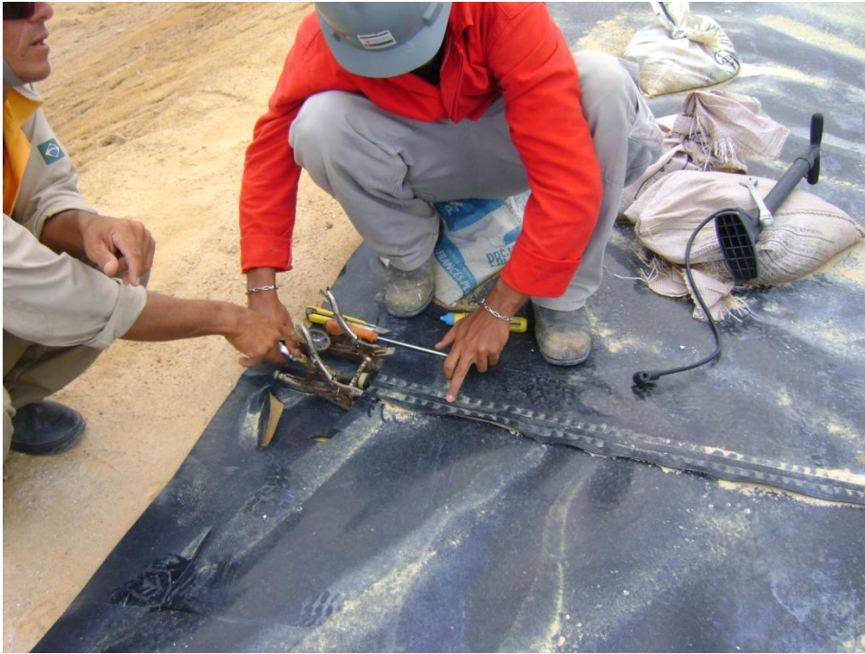
Figura 7.19– CL1: Execução de testes para detecção de vazamentos na geomembrana
