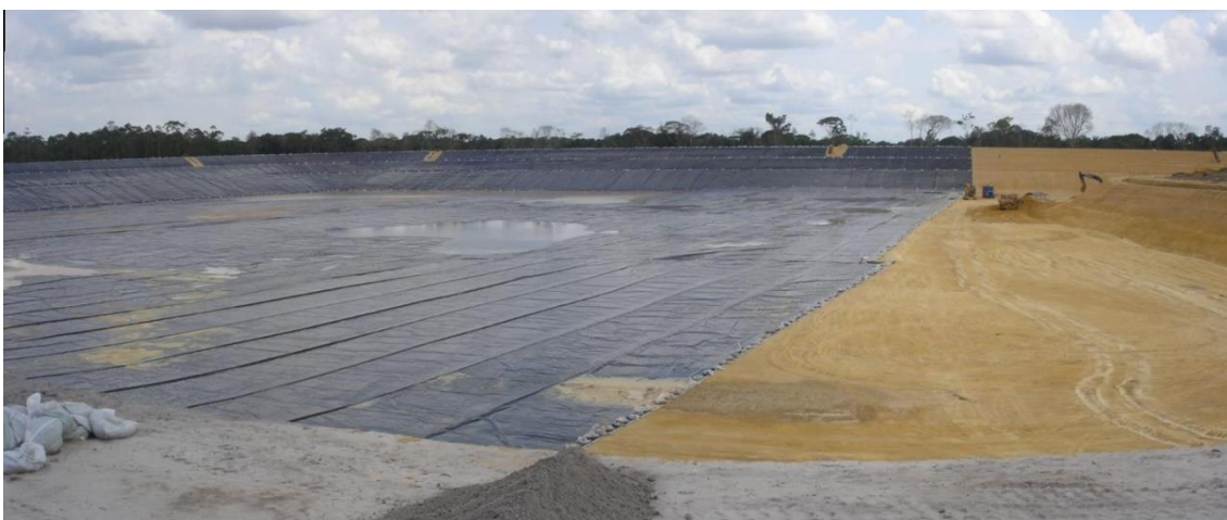
Figura 7.16 – Área Principal da Célula Sul com aproximadamente 110.000m 2 de geomembrana PEAD aplicados. Foto do dia 05/12/07 (RECORD, 2008)
