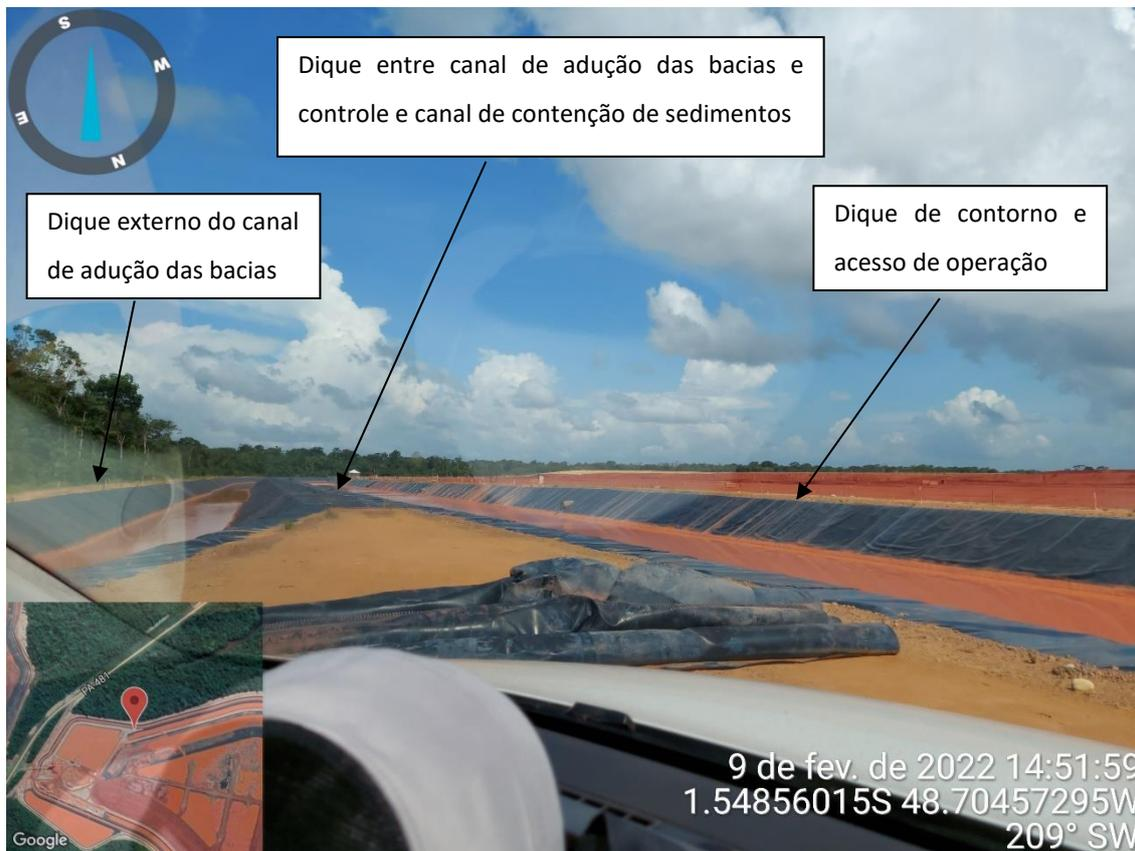
**Figura 5.9 – Identificação do dique externo, dique entre canal de adução e canal de contenção de sedimentos e dique de contorno e acesso de operação.**
