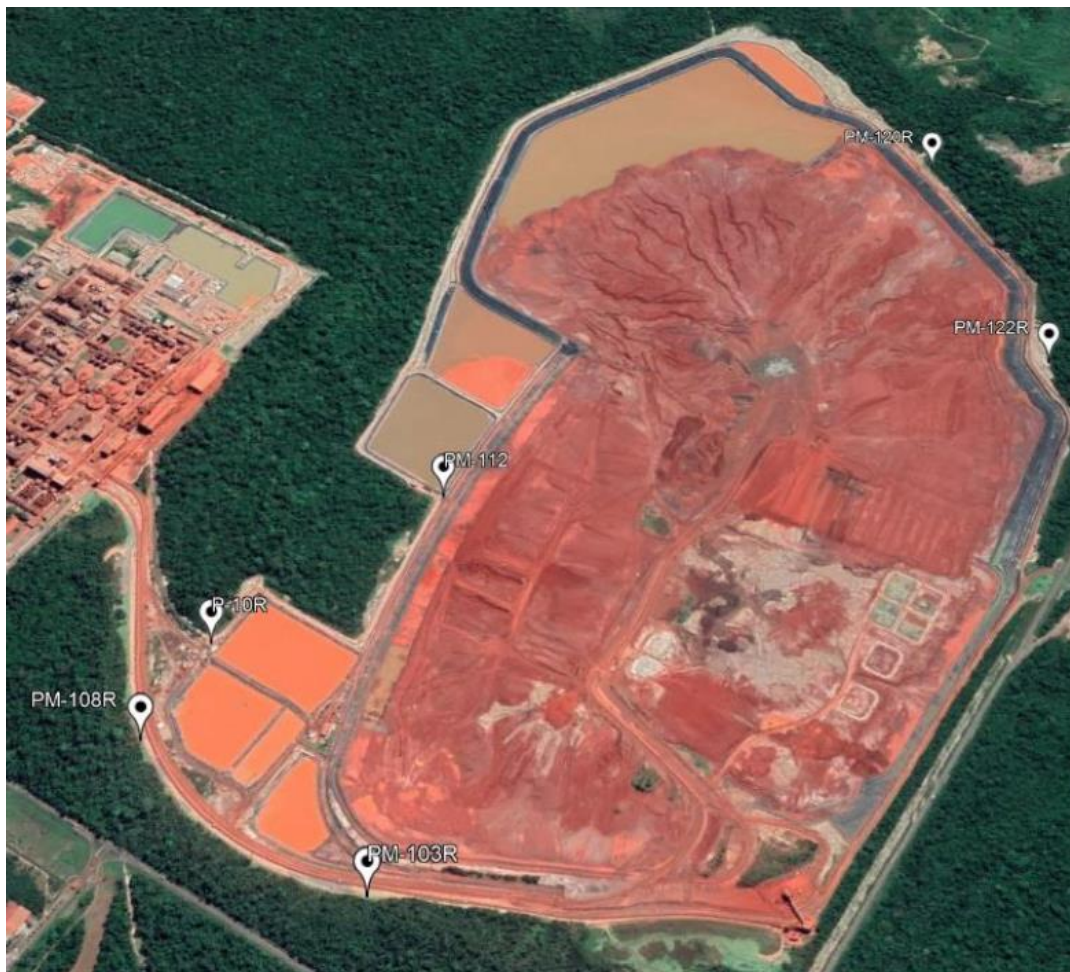
Figura 7.45 – Localização dos poços de monitoramento
