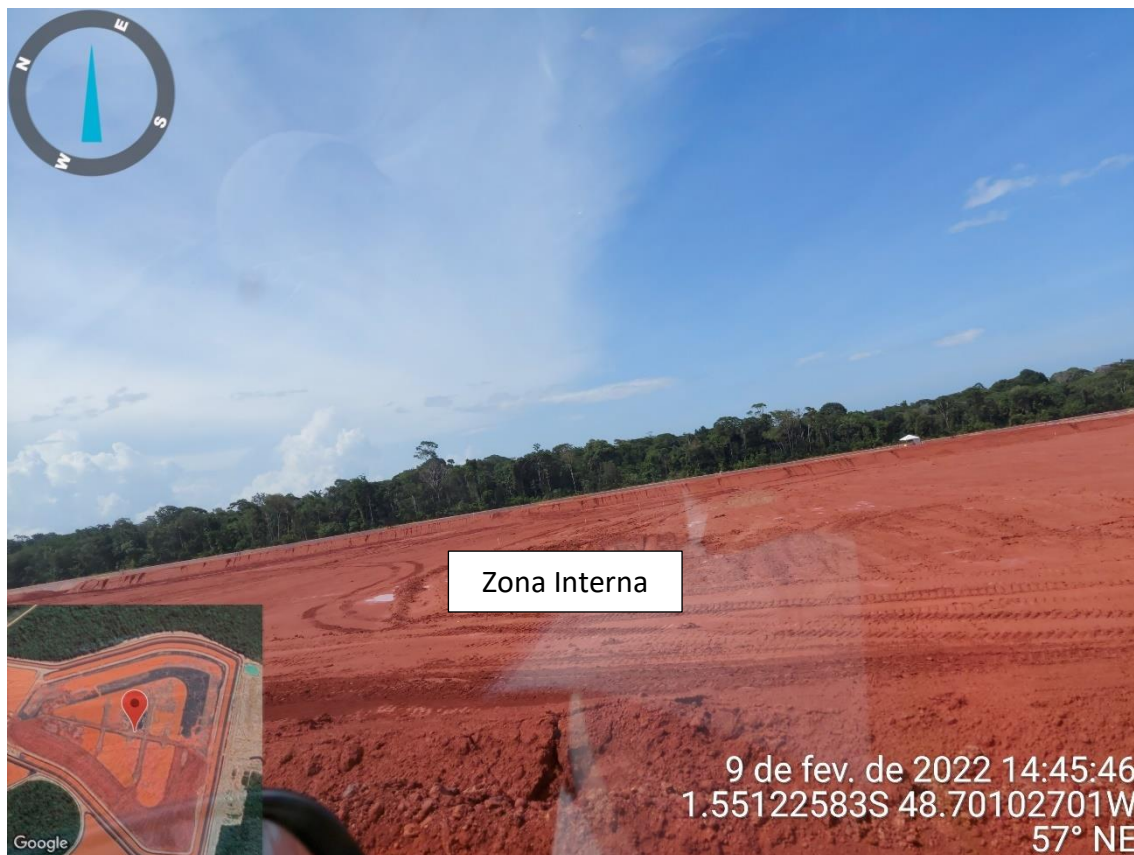
Figura 7.4 – Verificação da Zona Interna através de inspeção pelo acesso interno no centro da estrutura.
