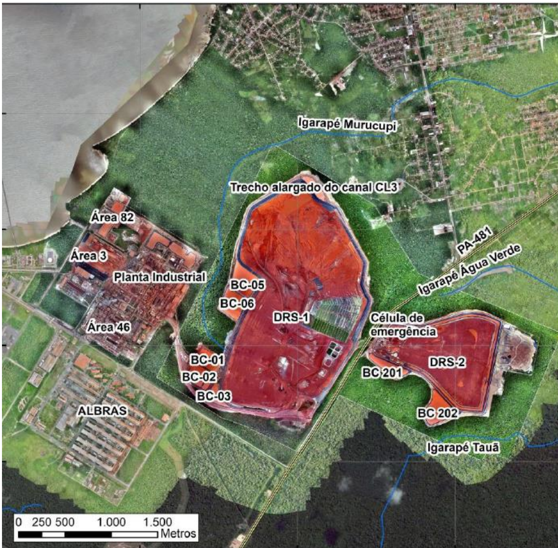
Figura 7.4 – Localização dos cursos d’água próximos dos depósitos de resíduos de acordo com o relatório de avaliação periódica dos resultados de monitoramento da instrumentação de dezembro/2021 (adaptado de PIMENTA DE ÁVILA, 2021)
